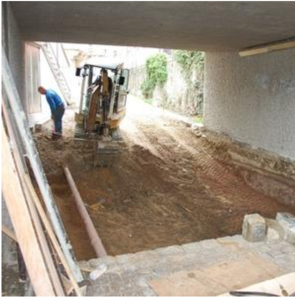
Überlaufbauwerk wird „ertüchtigt“
